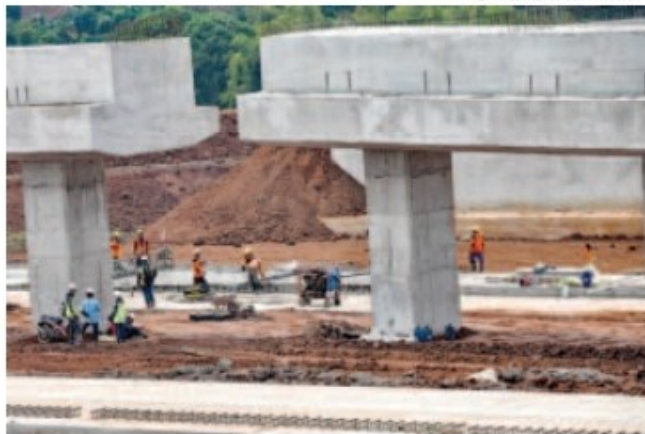
Proyek jalan tol Kunciran-Serpong di kawasan Pondok Aren, Tangerang Selatan, Banten, Juli 2018.
